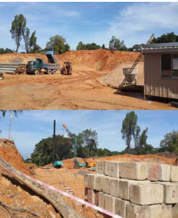
Kerja-kerja tanah dan menanam cerucuk.
